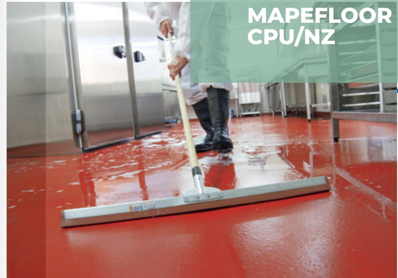
Облегченное в укладке полиуретан-цементное покрытие с высокой механической прочностью и стойкостью к химическим веществам и тепловым ударам для противоскользящих промышленных полов. Толщина 4-6 мм.
