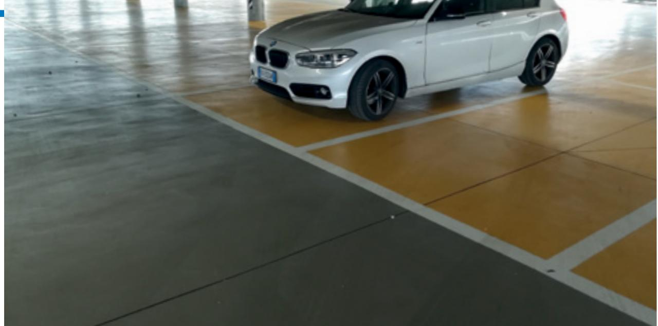
Бесшовное полиуретановое покрытие с отличной способностью к перекрытию динамических трещин для поверхностей с пешеходным и интенсивным автомобильным трафиком внутри помещений. Покрытие соответствует требованиям Rili DafStb (Методические рекомендации Немецкого комитета по железобетону), OS13. Может применяться для защиты бетонных поверхностей согласно EN 1504-2. Толщина 2-2,5 мм.
