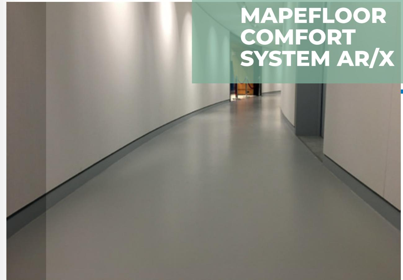
Полиуретановое ароматическое эластичное гибкое гладкое покрытие для полов в зданиях гражданского назначения. Толщина 6 мм.
