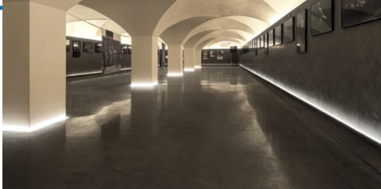
Гладкое цементное покрытие с очень быстрым набором прочности для износостойких полов с полированной поверхностью. Толщина 10-40 мм.
