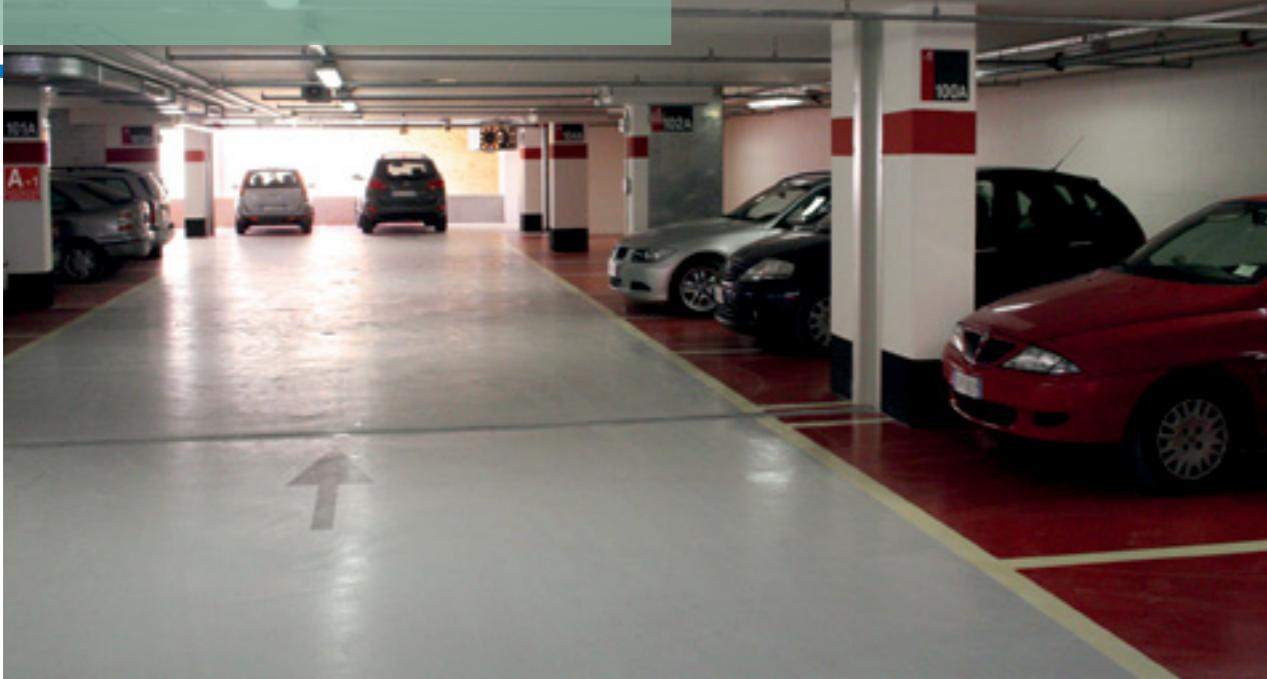
Бесшовное полиуретановое покрытие с отличной способностью к перекрытию динамических трещин для поверхностей с пешеходным и интенсивным автомобильным трафиком внутри и снаружи помещений. Покрытие соответствует требованиям Rili DafStb (Методические рекомендации Немецкого комитета по железобетону), OS 11b. Может применяться для защиты бетонных поверхностей согласно EN 1504-2. Толщина 4-4,5 мм.
