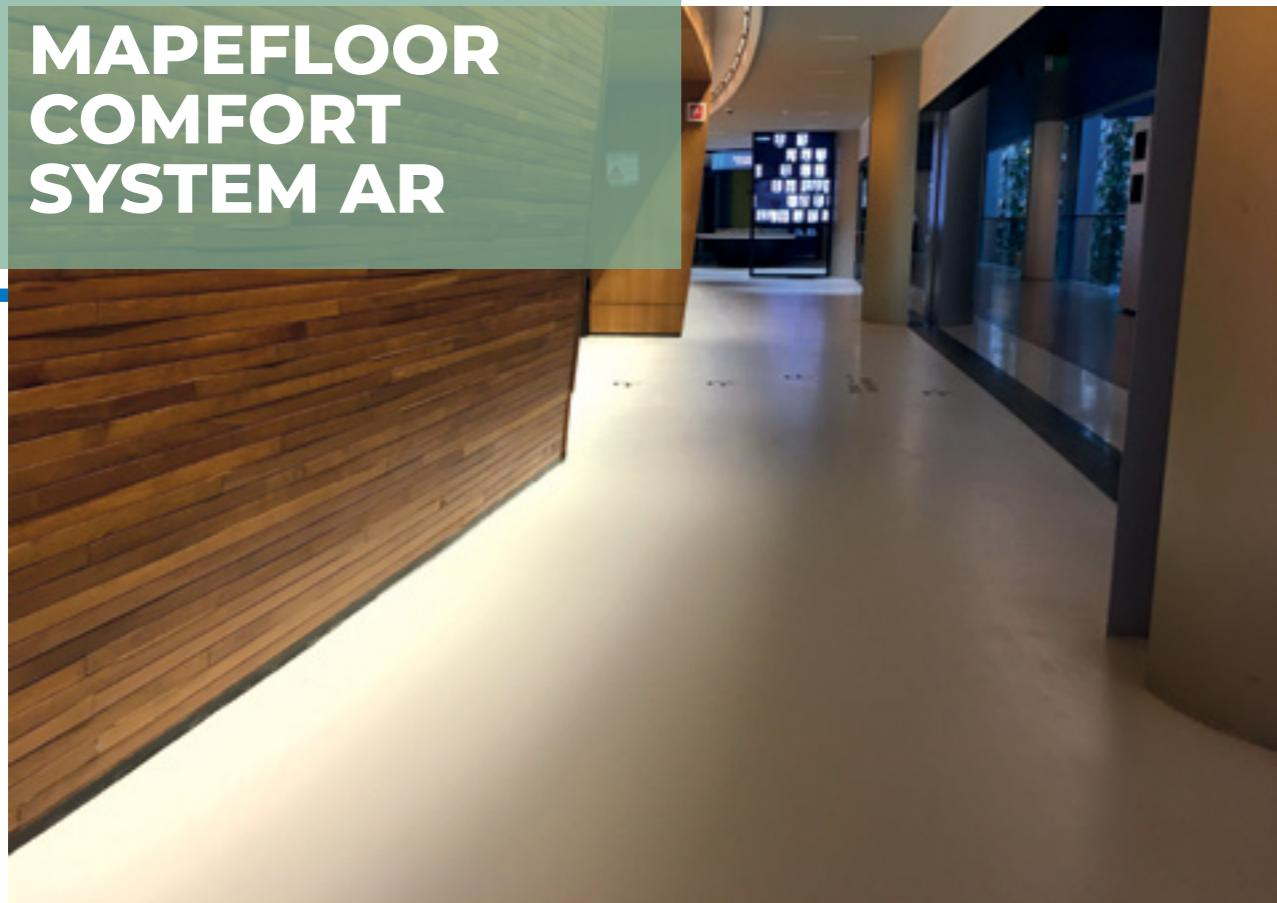
Полиуретановое ароматическое эластичное гладкое покрытие для полов в зданиях гражданского назначения. Толщина 2 мм.
