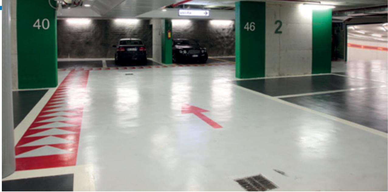
Бесшовное эпоксидное покрытие для поверхностей с пешеходным и интенсивным автомобильным трафиком. Покрытие соответствует требованиям Rili DafStb (Методические рекомендации Немецкого комитета по железобетону), OS8. Может применяться для защиты бетонных поверхностей согласно EN 1504-2. Толщина 0,8-1,2 мм.
