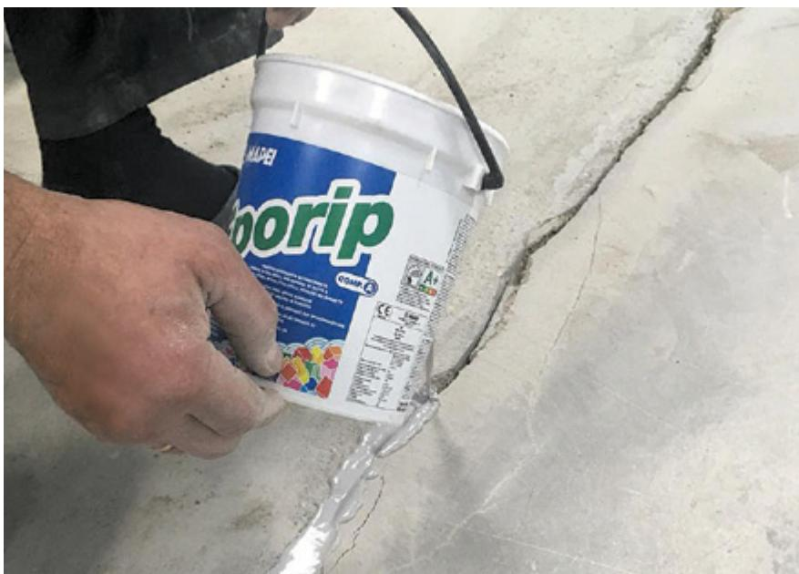
Заливка трещин в основании с помощью Eporip
