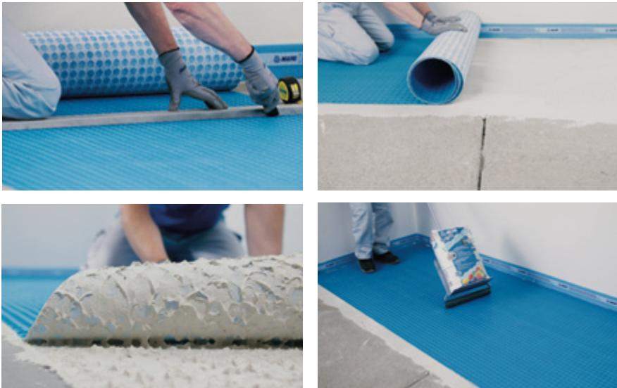
Процесс укладки Mapeguard UM 35
