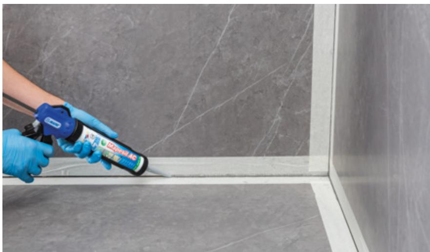
Герметизация шва по периметру с помощью Mapei AC
