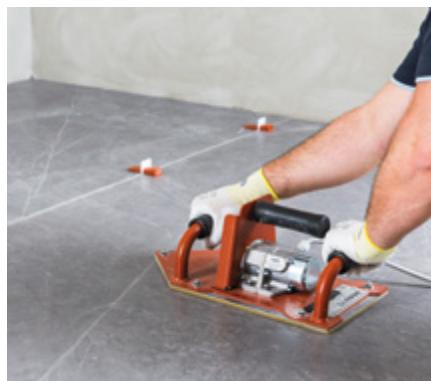
Простукивание плитки вручную или с помощью вибропанели
