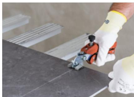
Разламывание плитки с помощью щипцов для надлома
