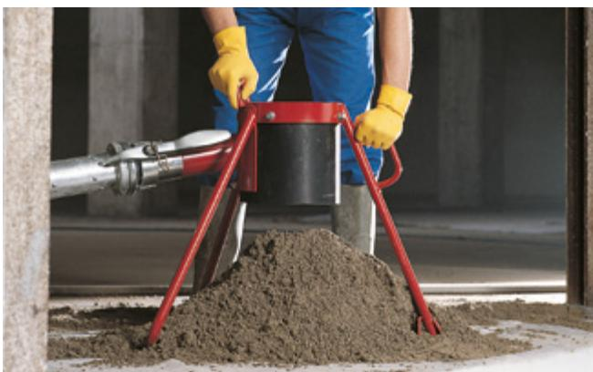
Укладка стяжки с помощью **Topcem Pronto**
